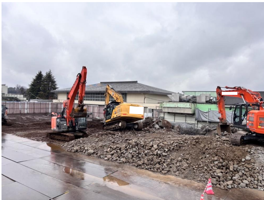
現場事務所から現場内を撮影
