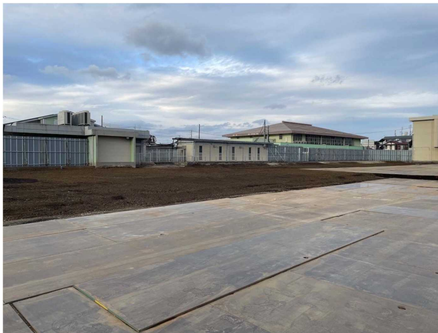
西棟校舎解体完了状況を撮影
