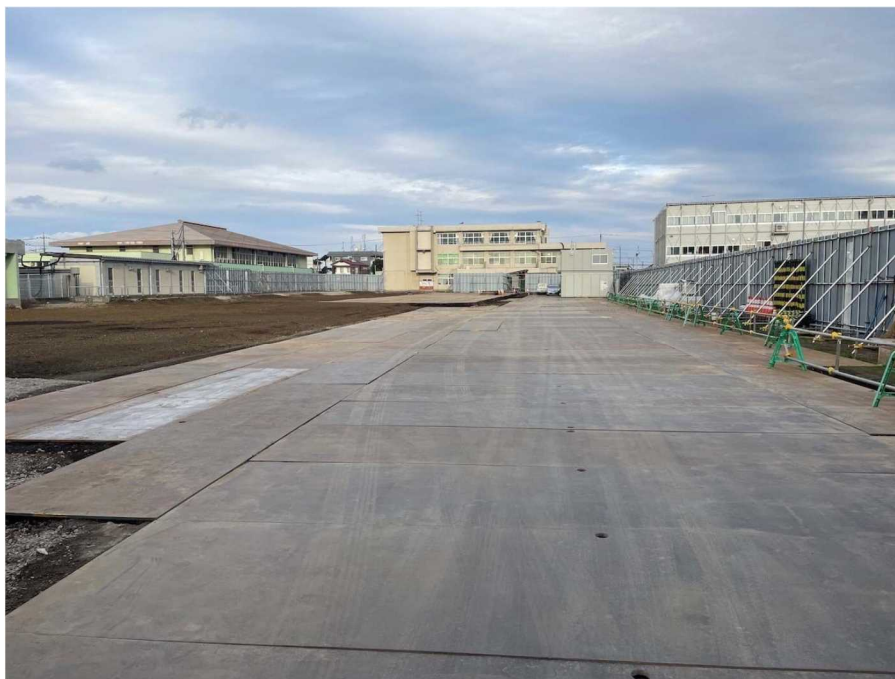
中央棟校舎解体完了状況を撮影
