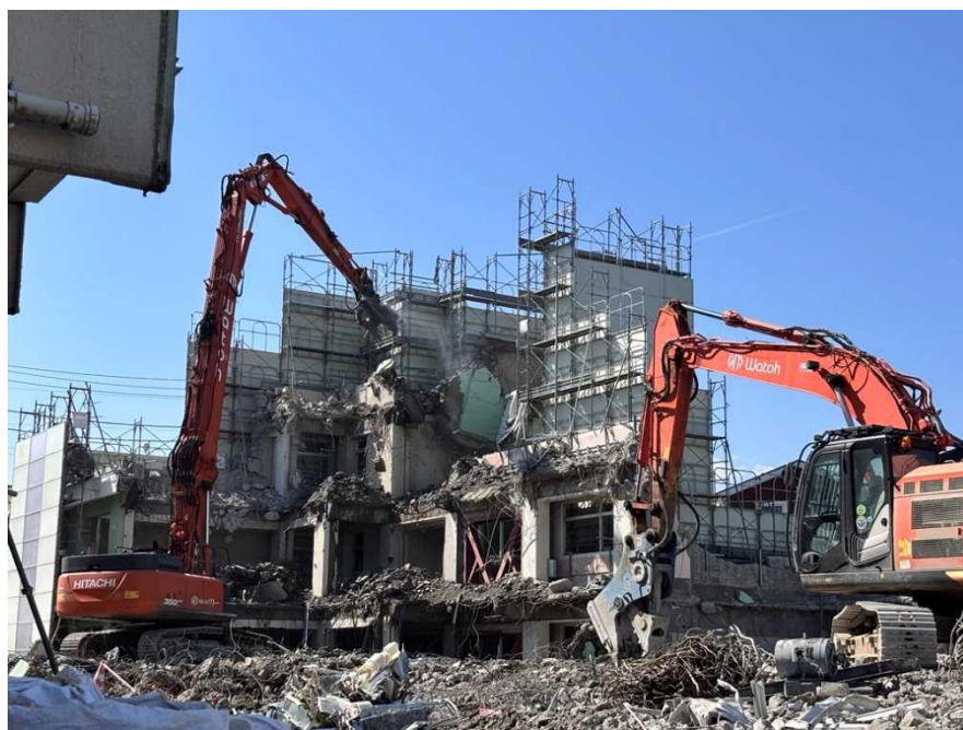
西棟校舎解体状況を撮影
