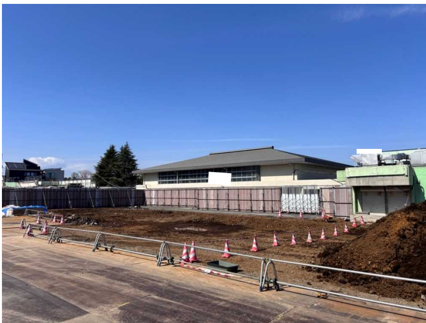
東棟校舎解体状況を撮影
