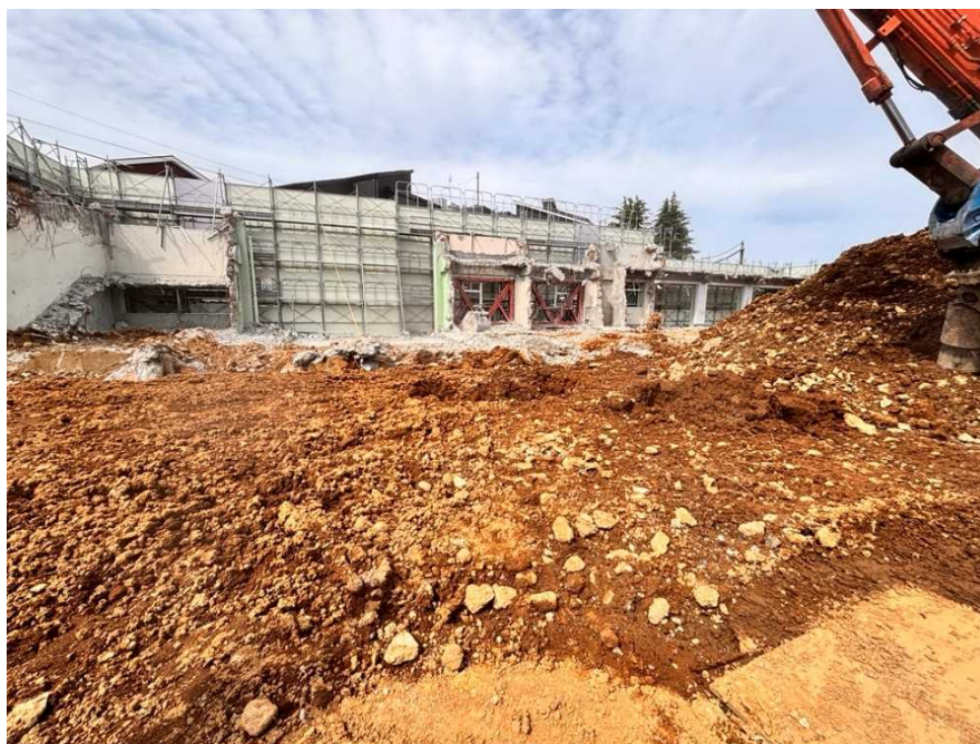
西棟校舎解体状況を撮影
