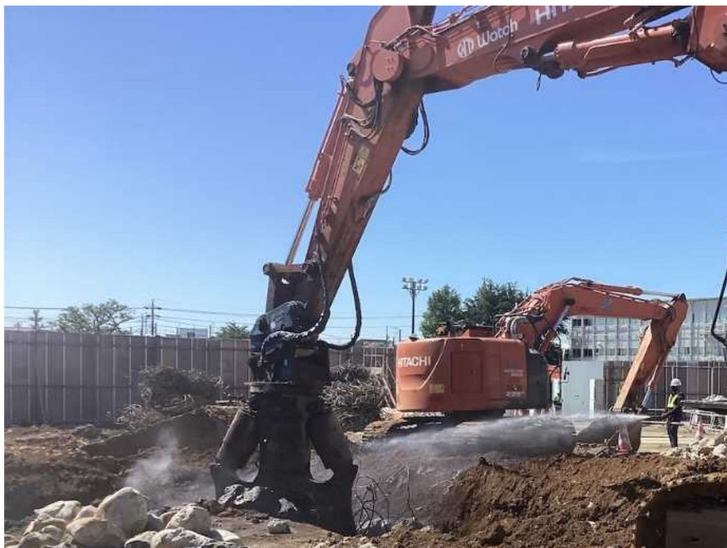
西棟校舎解体状況を撮影
