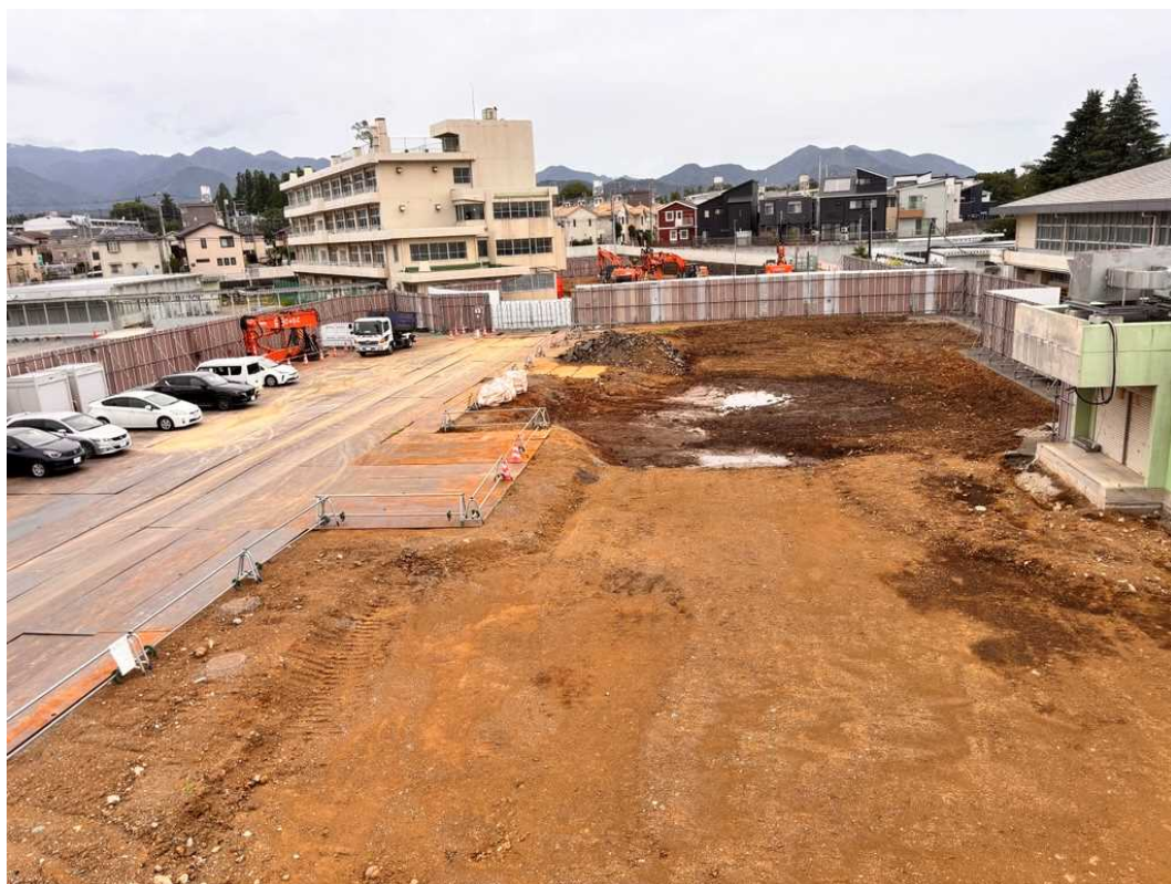
解体状況を撮影
