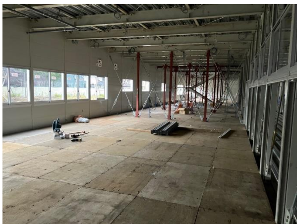
仮設校舎1階多目的室を撮影 ・床下地材の施工状況です。
