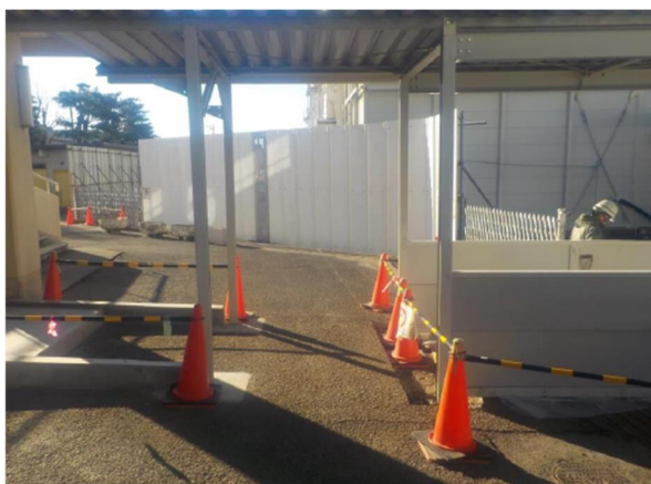
仮設渡り廊下を撮影
