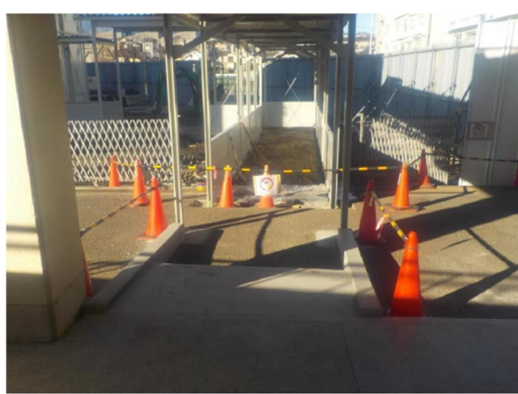
仮設渡り廊下を撮影
