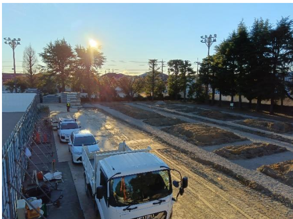
工事エリア内を撮影
