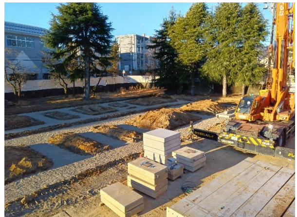
工事エリア内を撮影
