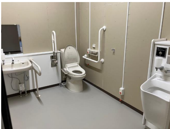
バリアフリー対応トイレを撮影
