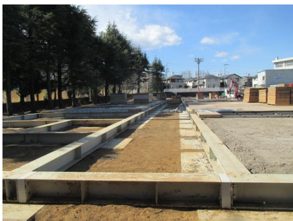
基礎の完成状況を撮影
