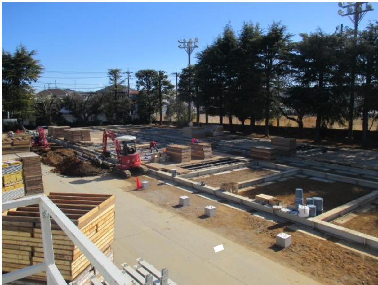
工事現場内を撮影
