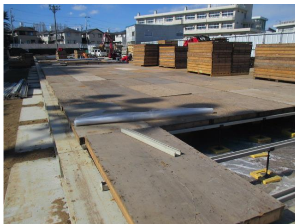
1階床の施工状況を撮影
