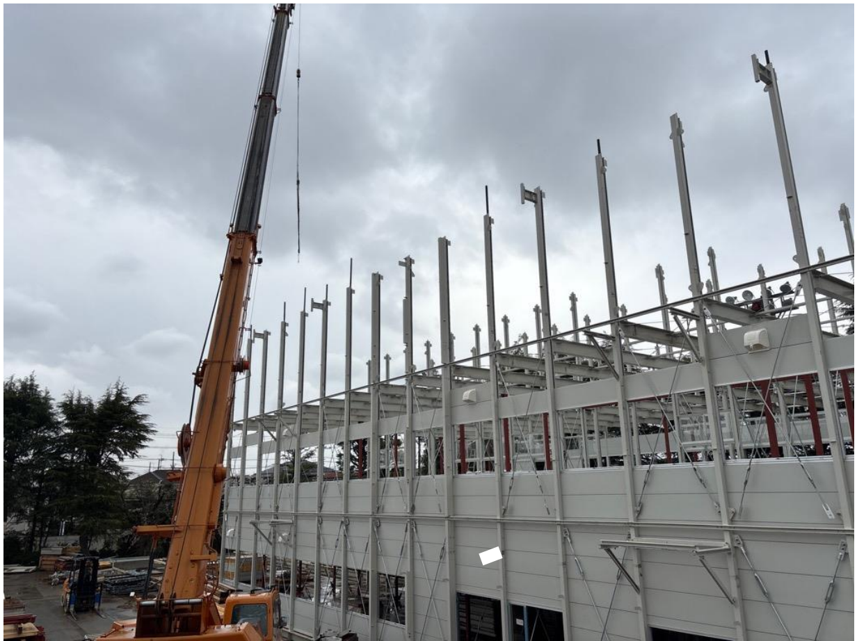
工事現場内を撮影
