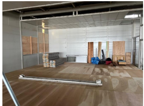
3階の施工状況を撮影
