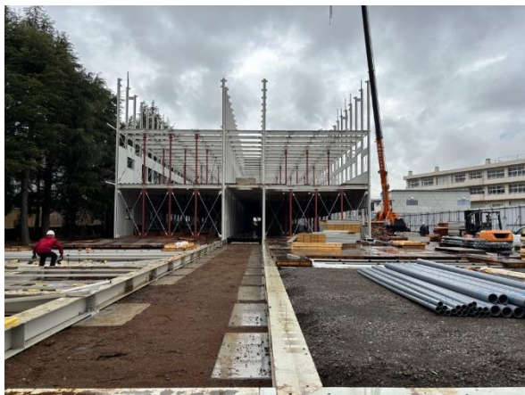
1階廊下を撮影
