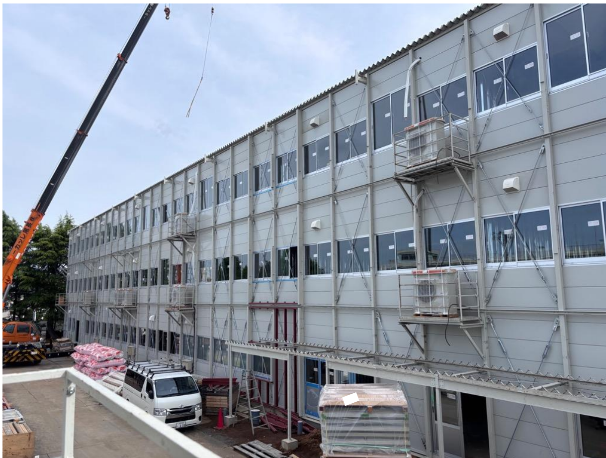
工事現場内を撮影
