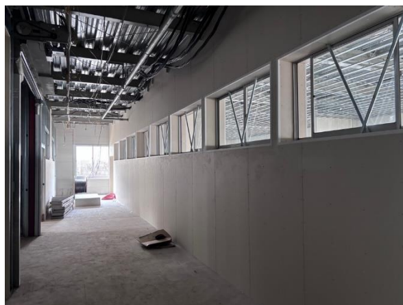
1階の施工状況を撮影
