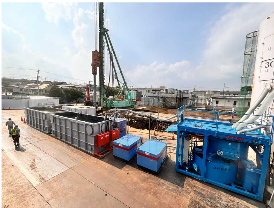
地盤改良状況を撮影
