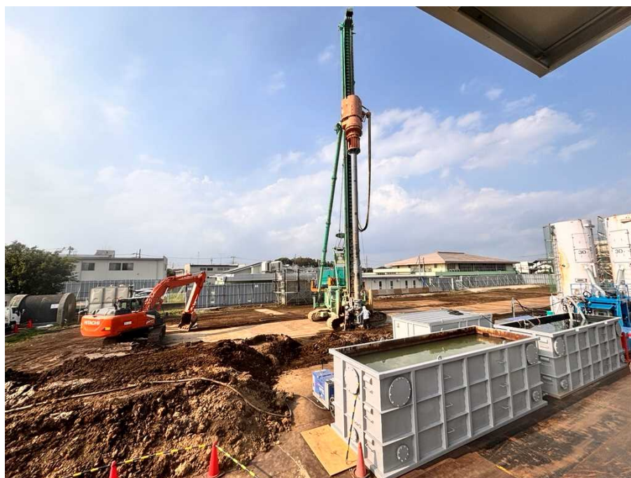
地盤改良状況を撮影
