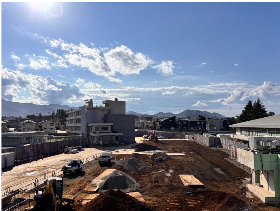
現場事務所から現場内を撮影
