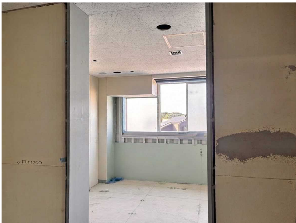
南棟トイレを撮影
