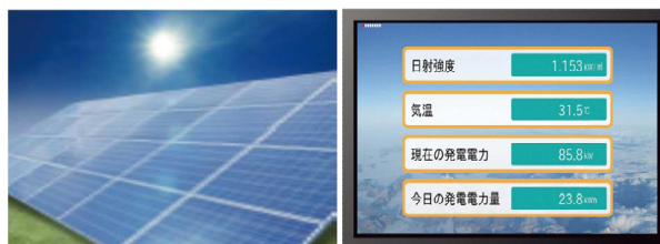
太陽光発電の設置
