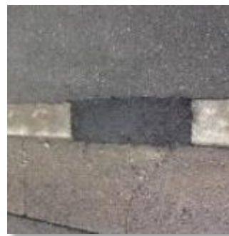
修繕後の写真 道路(縁石の破損／常温合材による修復)
