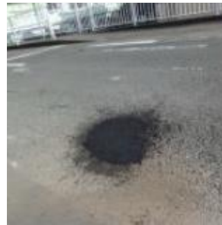
修繕後の写真 道路(穴ぼこ／常温合材による修復)
