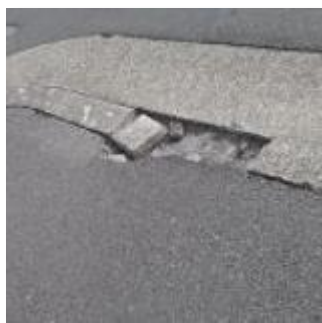
情報提供いただいた写真 道路(縁石の破損／縦10cm幅20cm程度)
