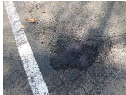
修繕後の写真 道路(穴ぼこ／常温合材による修復)
