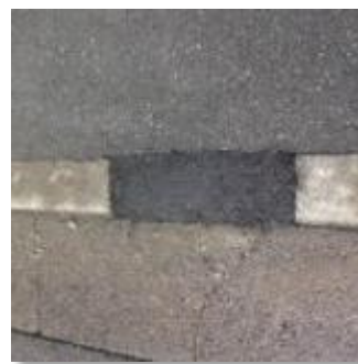
修繕後の写真 道路(縁石の破損／常温合材による修復)
