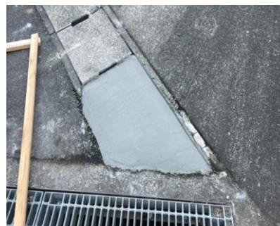
修繕後の写真 道路(甲蓋の補修)
