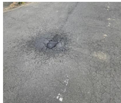
修繕後の写真 道路(穴ぼこ／常温合材による修復)
