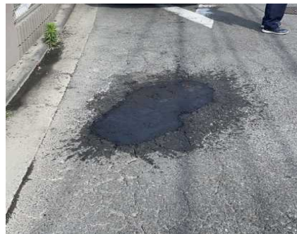
修繕後の写真 道路(穴ぼこ／常温合材による修復)
