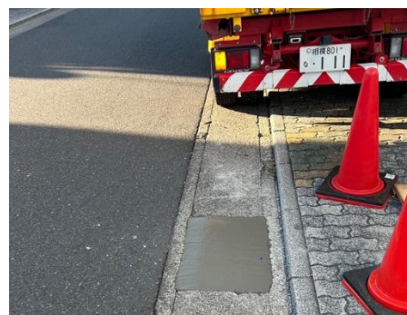
修繕後の写真 道路(側溝の補修)
