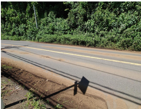
撤去個所の写真 車道(土砂の撤去)
