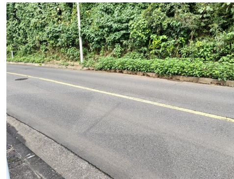
修繕後の写真 車道(土砂の撤去)
