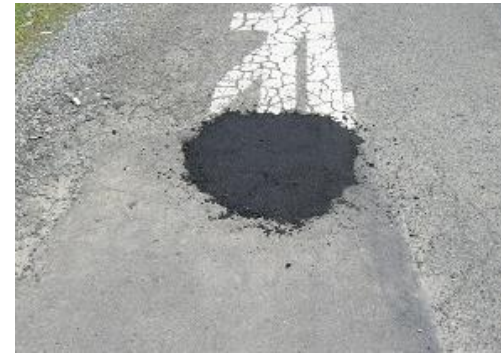
修繕後の写真 道路(穴埋め／常温合材による修復)
