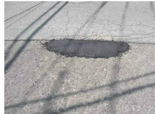
修繕後の写真 車道(舗装段差擦り付け)
