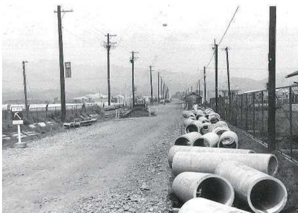
昭和37年ごろ 尼寺原工業団地造成
