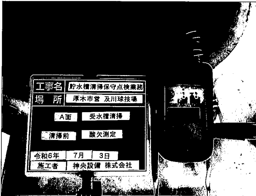
厚木市営 及川球技場 A面 上水受水槽清掃 受水槽 清掃前 酸欠測定
