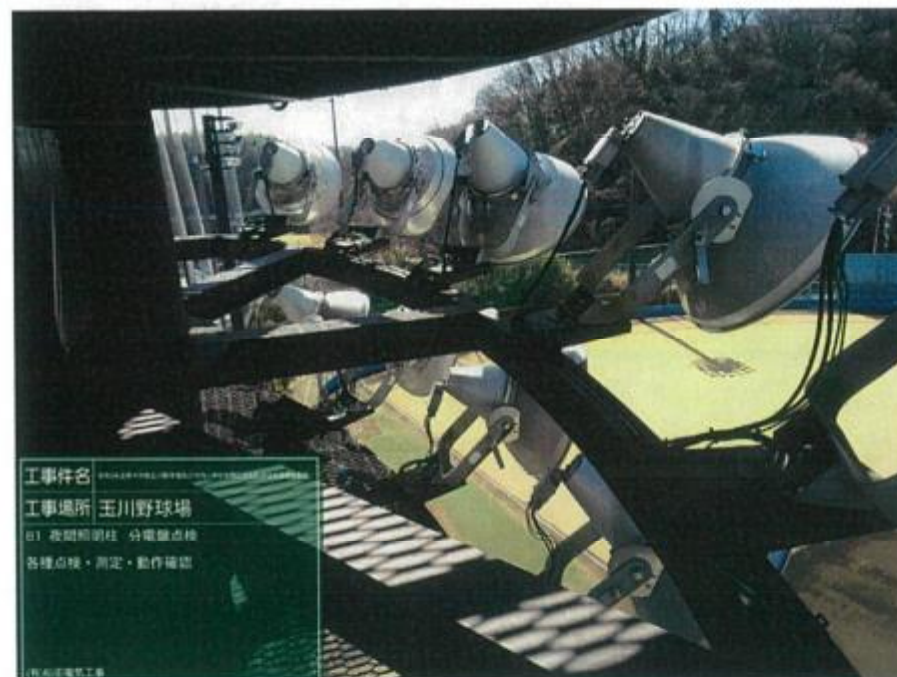
工事件名 工事場所 玉川野球場 B1 夜間照明柱 分電盤点検 各種点検・測定・動作確認 (株)山電電気工事
