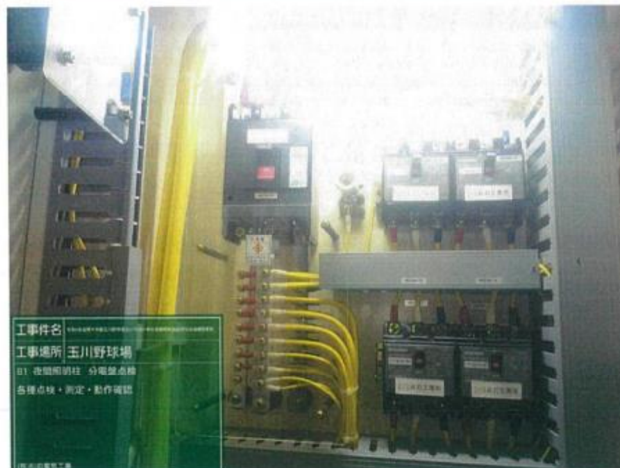
工事件名 工事場所 玉川野球場 B1 夜間照明柱 分電盤点検 各種点検・測定・動作確認
