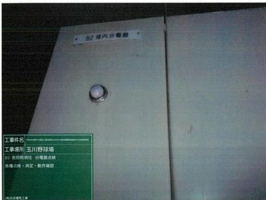
工事件名 工事場所 玉川野球場 B2 夜間照明柱 分電盤点検 各種点検・測定・動作確認 (有)利正電気工事
