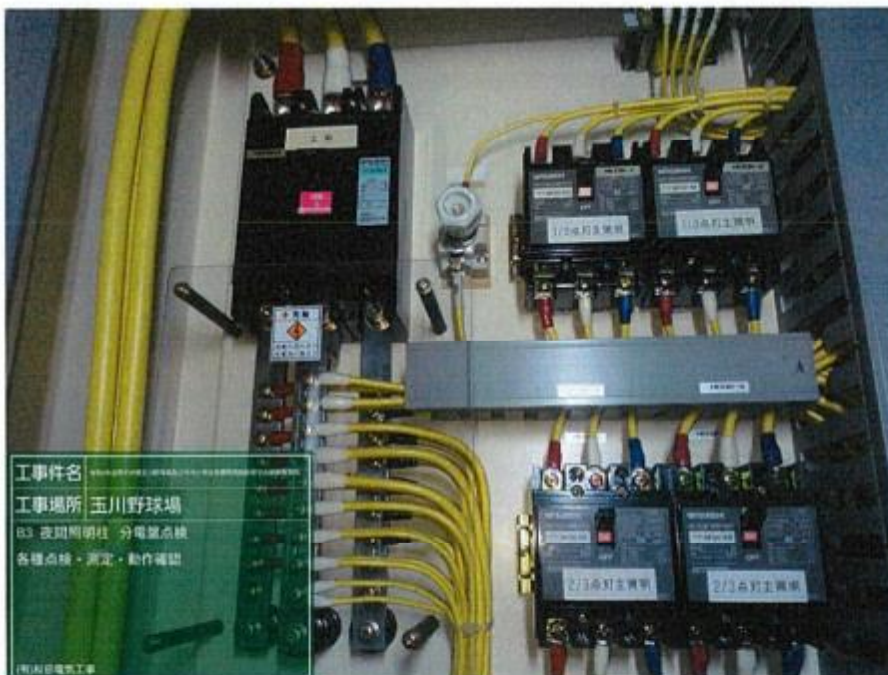
工事件名 工事場所 玉川野球場 B3 夜間照明柱 分電盤点検 各種点検・測定・動作確認 (株)日通電気工事
