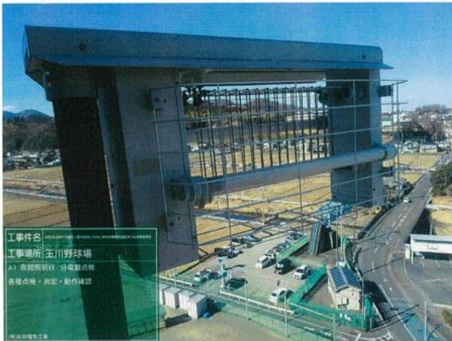
工事件名 夜間照明の点検・調整・動作確認 工事場所 玉川野球場 A1 夜間照明柱・分電盤点検 各種点検・測定・動作確認 株式会社電気工事
