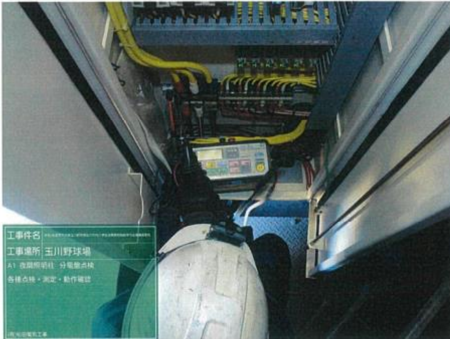
工事件名 夜間照明柱・分電盤点検 工事場所 玉川野球場 A1 夜間照明柱・分電盤点検 非常電源盤 各種点検・測定・動作確認 株式会社電気工事
