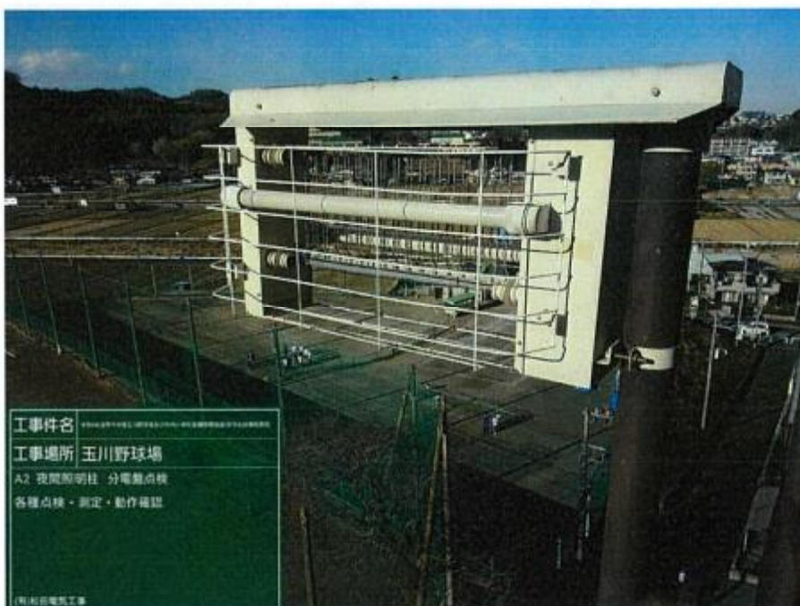
工事件名 玉川野球場 工事場所 玉川野球場 A2 夜間照明柱 分電盤点検 各種点検・測定・動作確認 株式会社電気工事
