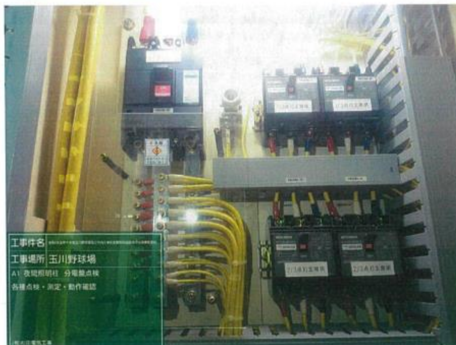
工事件名 玉川野球場 夜間照明柱 分電盤点検 工事場所 玉川野球場 A1 夜間照明柱 分電盤点検 各種点検・測定・動作確認 株式会社電気工事
