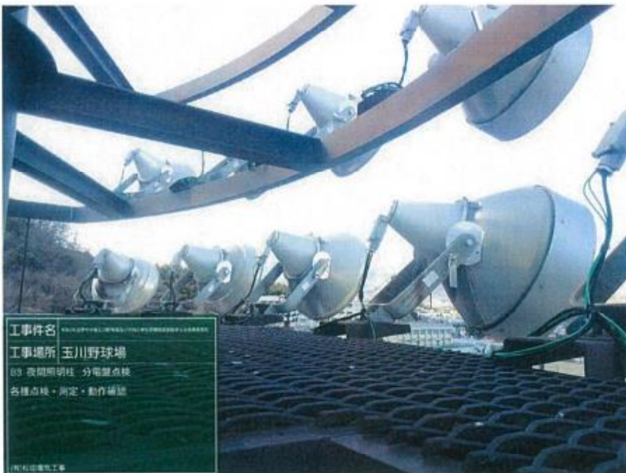
工事件名 玉川野球場の夜間照明設備の点検・保守 工事場所 玉川野球場 B3 夜間照明柱・分電盤点検 各種点検・測定・動作確認 有限会社電気工事
