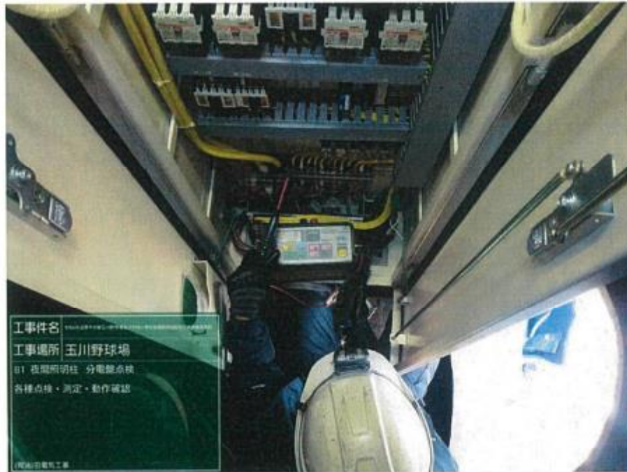
工事件名 工事場所 玉川野球場 B1 夜間照明柱 分電盤点検 非常電源盤 各種点検・測定・動作確認 (株)山電電気工事
