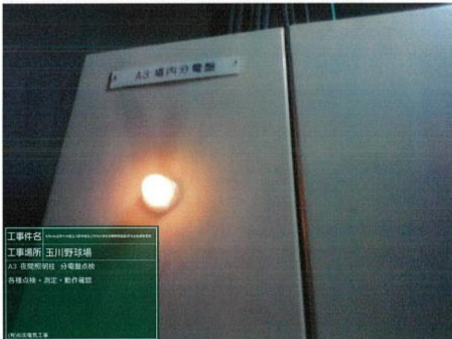
工事件名 工事場所 玉川野球場 A3 夜間照明柱 分電盤点検 各種点検・測定・動作確認
