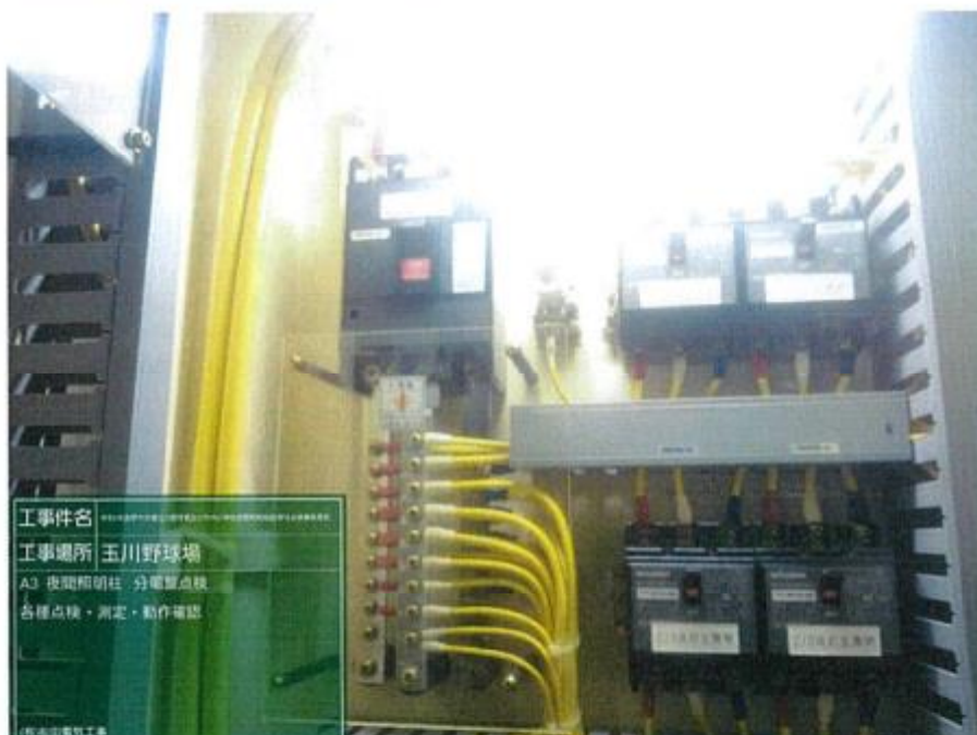
工事件名 工事場所 玉川野球場 A3 夜間照明柱 分電盤点検 各種点検・測定・動作確認
