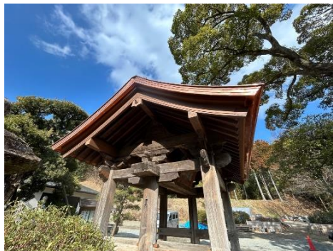
新調した左側破風板
