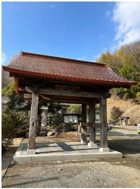
修理後の全体像
