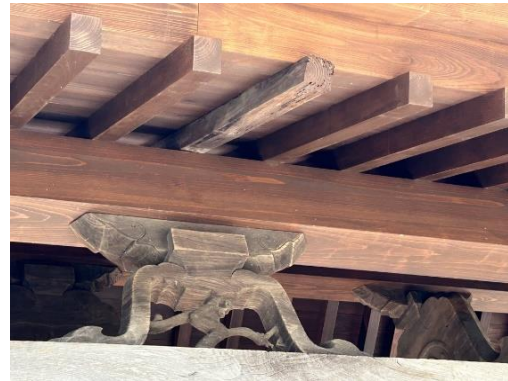
一部旧材を使用した垂木
