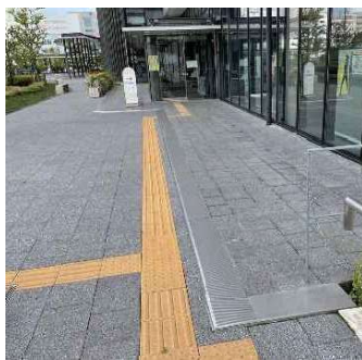
誘導ブロック設置
