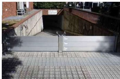
着脱式止水板
