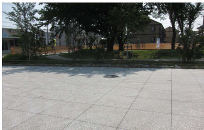
アスファルト半たわみ舗装
