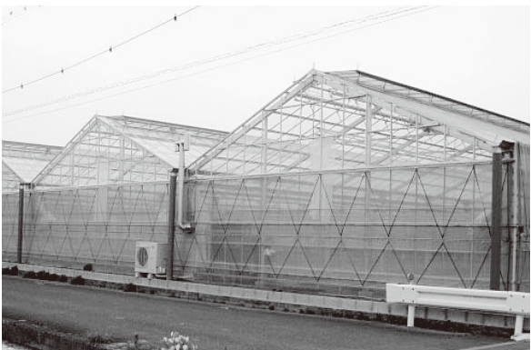
支援事業を活用して復旧した農業施設（ハウス）
