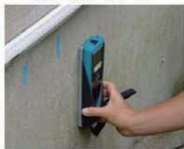
「基礎配筋」の調査機器
