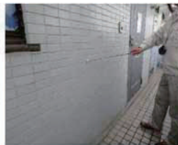
「外部（外壁）」調査の様子
