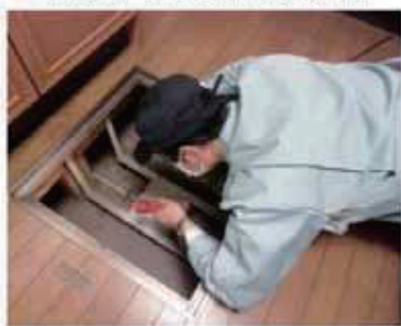
「土台・床組、基礎」調査の様子
