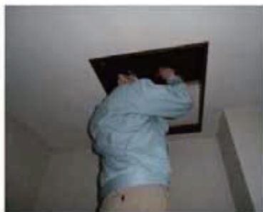
「小屋組・梁」調査の様子
