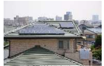
太陽光パネル
